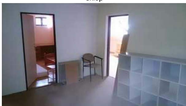
byt v podkroví
